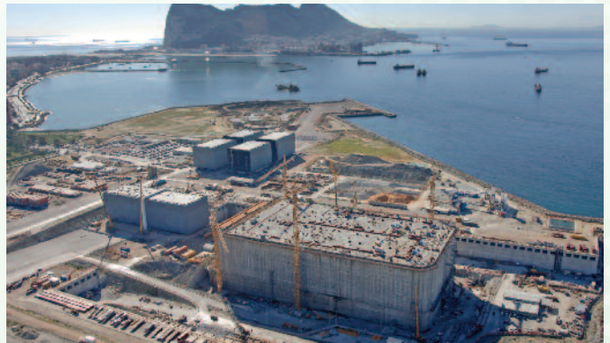
Modular LNG tanks, Adriatic LNG - from concept to construction.
